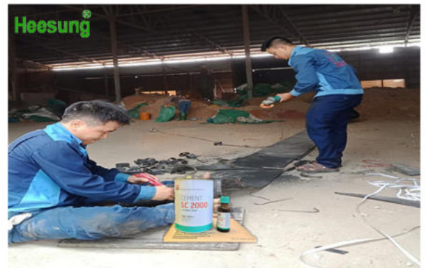
Dán nối nguội tại công trường
